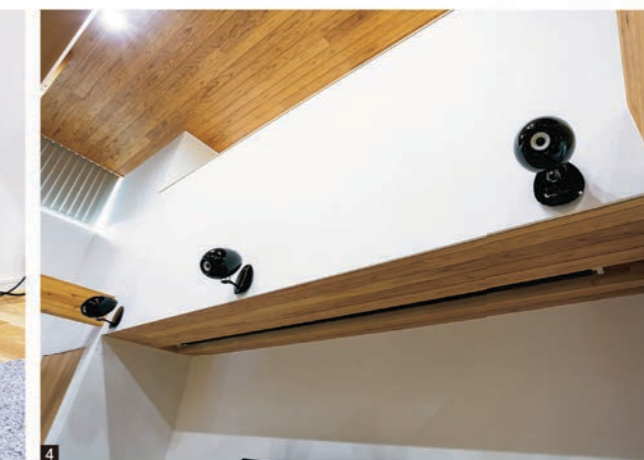
4フロントとセンタースピーカーはイクリプス「TD508MK3」を選び、壁掛け設置している。5サブウーファーはイクリプスの「TD316SWMK2」をチョイス。約50量の広さとバランスを取るため、16cmのウーファーを対向配置し、コンパクトながらパワフルなモデルを選んだという。6天井近くまで続くふかし壁を掘り込み、スクリーンを設置している。
