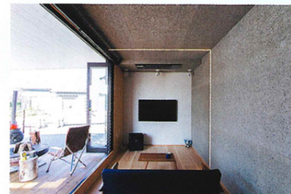
室内の壁や天井には木毛セメント板を設置。断熱効果、調湿効果、吸音効果がある材質だ。さらにラインLEDを仕込み、空間のアクセントとしている。窓は開放でき、ウッドデッキと繋げて使用することもできる。
