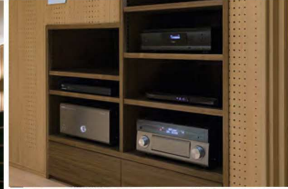
アンプにはヤマハのセパレートタイプ「CX-A5100」、「MX-A5000」を使い、全チャンネルのバランスを整えた。またラックは今後の機器拡張も見越して、余裕あるスペースを確保している。
