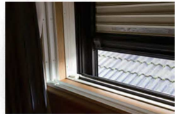
お一人でご覧になるので、椅子はストレスチェアにしたという。ホームオートメーションシステムを導入し、iPadでAV機器からエアコン、照明までワンタッチで操作できるようにした。窓は2重サッシにし、シャッターをつけることで音漏れと遮光対策も万全。
