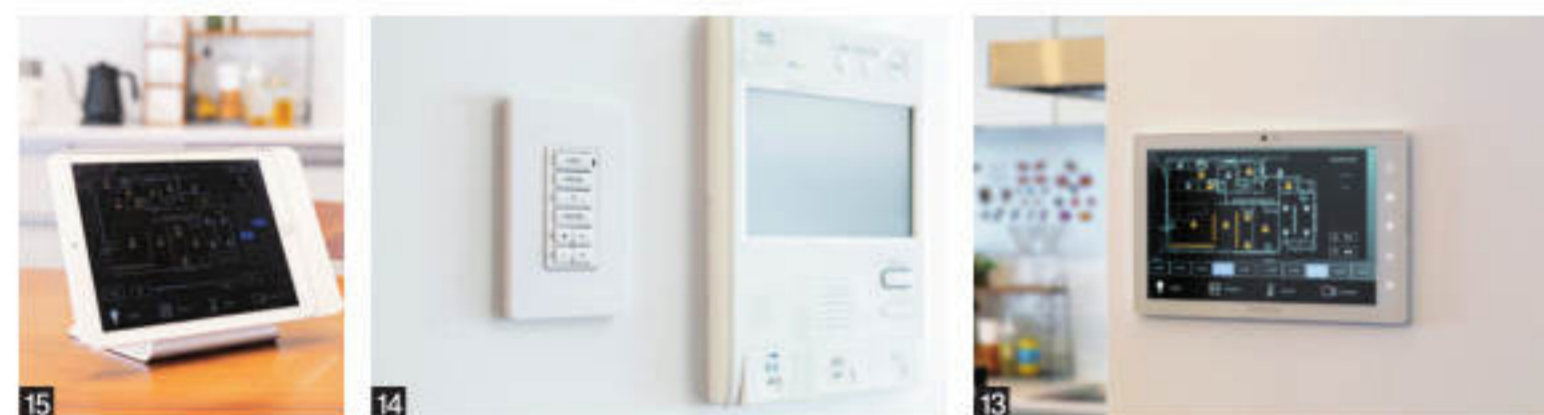
12 クレストロン専用の操作タブレット。表示されているのは照明をコントロールする画面で、各部屋の照明ボタンを押すだけでON/OFFの切り替えができる。13 物理ボタンも用意している。こちらは部屋の入り口に用意しており、ワンボタンで家中の照明やエアコンのON/OFFができるので、外出する際など、消し忘れがなくて便利だという。15 iPadでも操作できる。できることは専用の操作タブレットと同様だ。
