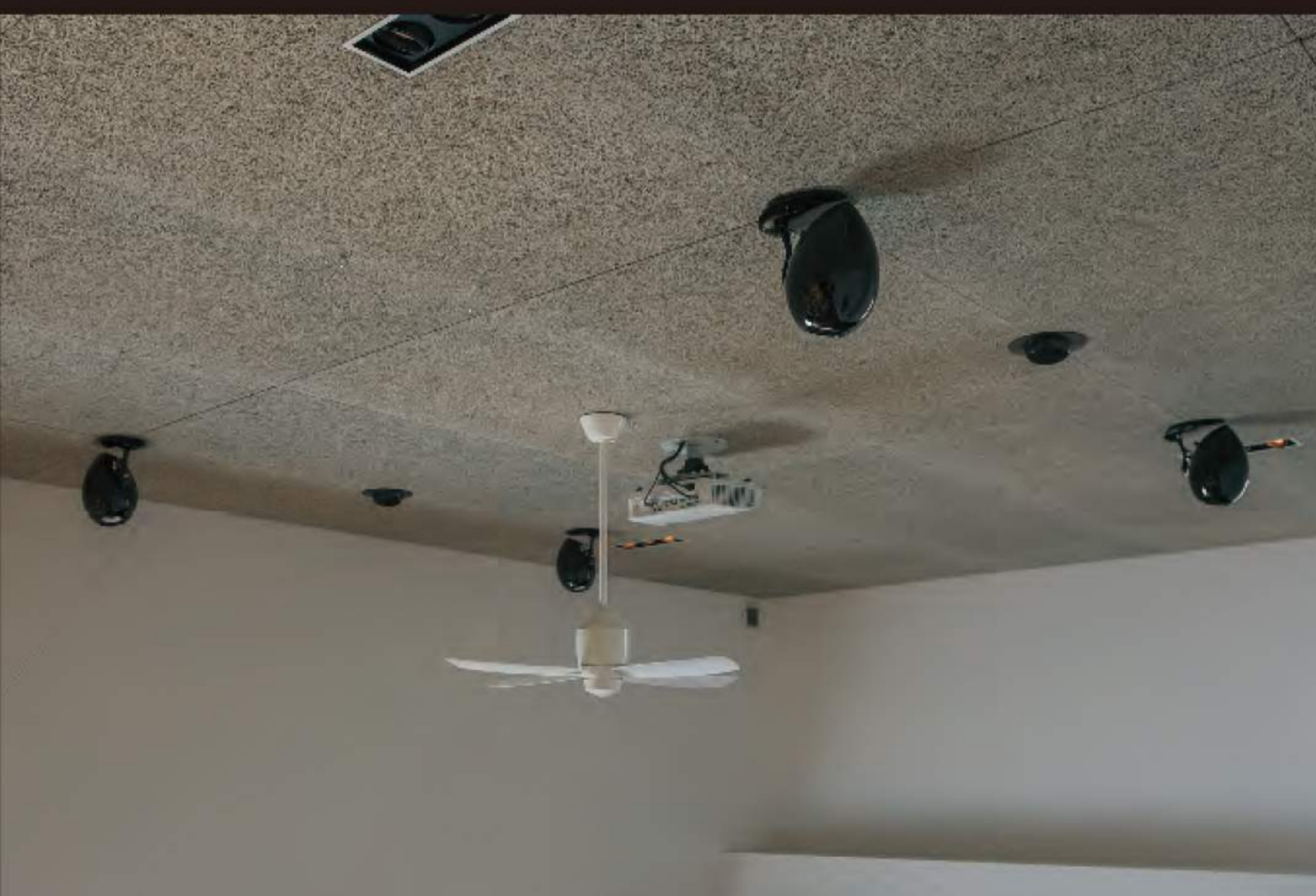
↓シアタールームは約5mもある吹き抜けになっている。その天井に設置されるのは4本のTD508MK3だ
